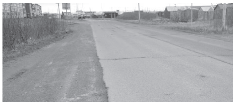
Осмотр дорог в п. Усть-Камчатке / ФОТО «УКВ»
