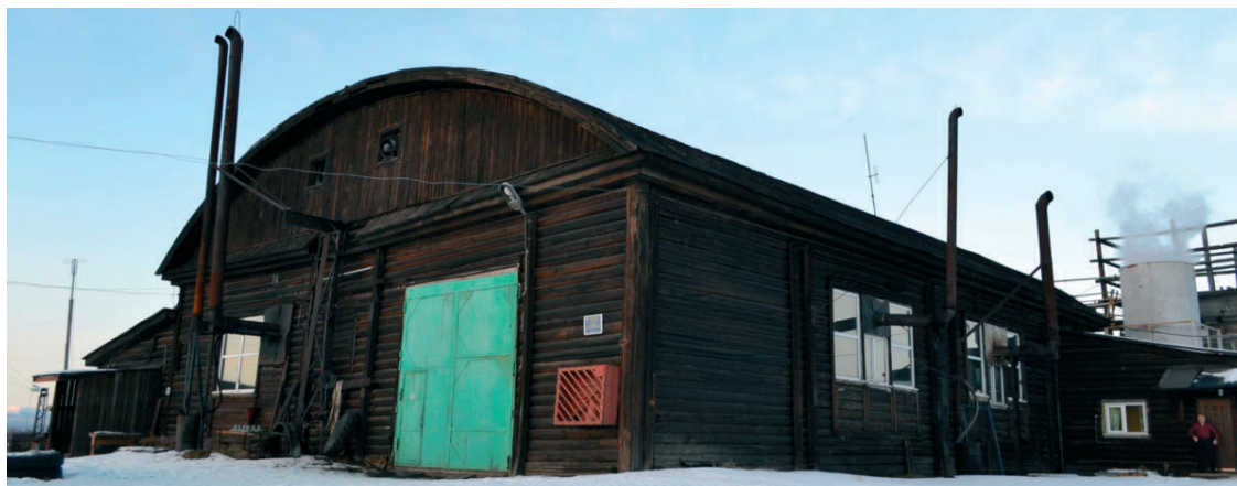
Рисунок 2.22 – здание дизельной электростанции «ДЭС-16»
